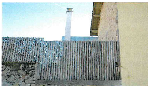
ganivelle doublée d'une canisse (ici sur mur)
