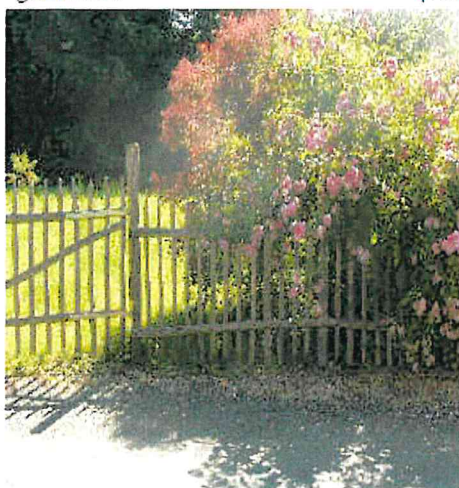
panneau en échelas de châtaignier (80à100cm) doublé de végétation
