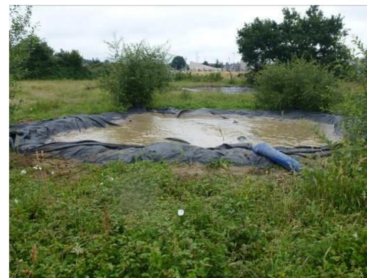
Figure 88 : Bassin de décantation pour les eaux turbides issues d'une niche de forage
