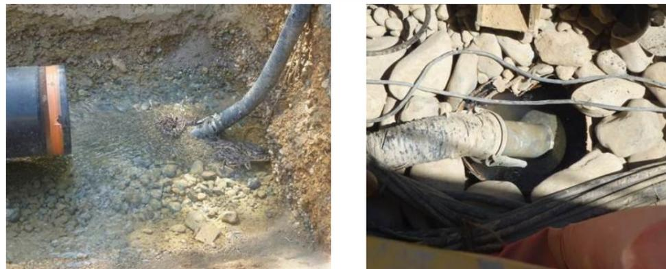
Figure 84 : Exemple de pompe enfouie dans les graviers en fond de fouille ou posée dans une structure métallique entourée de galets afin de diminuer le pompage de MES à la source
