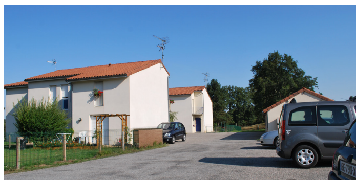
Logements collectifs - village de Taillac (photo BE HG Territoires-2015)
