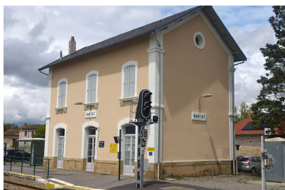
Gare de Nantiat (photo Internet - source inconnue)
